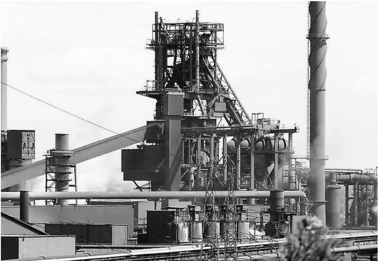
Schmelzwerk I à Duisburg, cliché de 2002 : propriété de Thyssenkrupp Stahl AG, construit en 1973, 110 m de haut, creuset de 14 m, produit 10 000 t. de fonte par jour, soit 68 millions de t en 30 ans.
