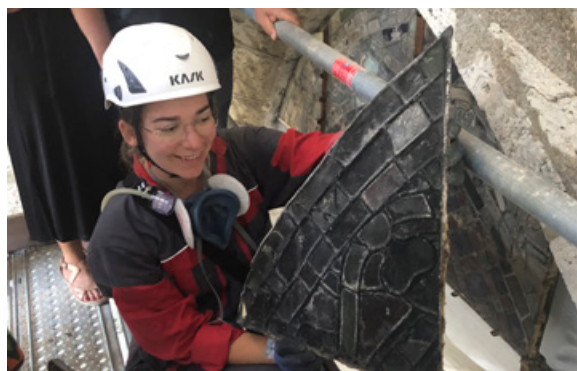
La dépose des verrières.
